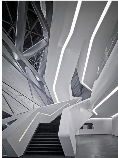
الهيكل الإنشائي للقشرة الخارجية يظهر داخل المبنى بشكل كبير
