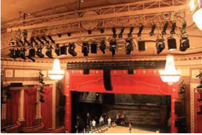
حلقة لتركيب مكبرات الصوت بشكل مقوس ليغطي الصالة بأكملها
