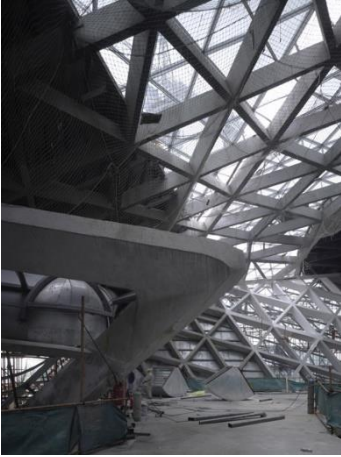
شكل القشرة الخارجية المكونة من المثلثات المكررة
